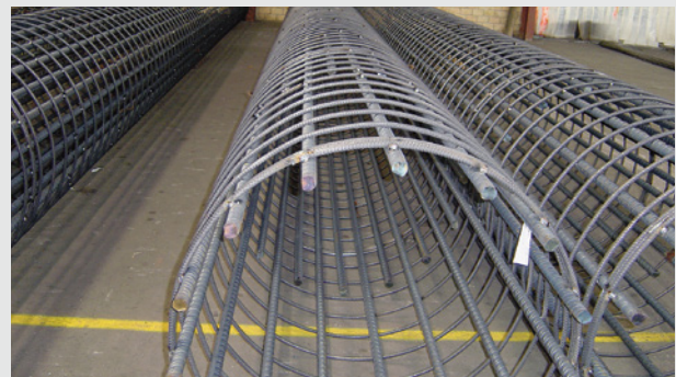
Bohrpfahlbewehrung
